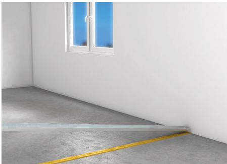
Montage af stålprofiler i top- og bundskinne af stål.
