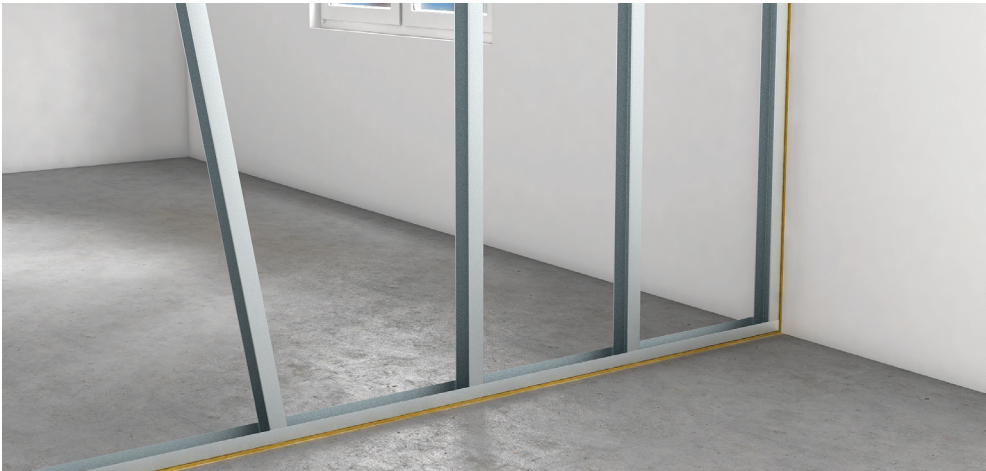
Montage af CW-stålprofiler.
