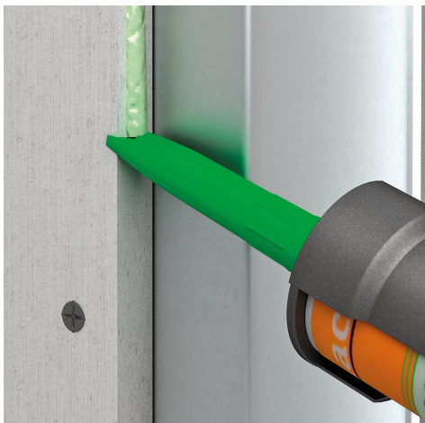
Påfør fermacell™ Fugeklæber midt på pladens kant
