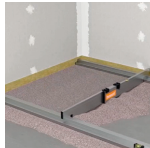
Figur 6 Udjævning imellem dæmningerne (Se 0,55 sek. i montagevideoen.)
