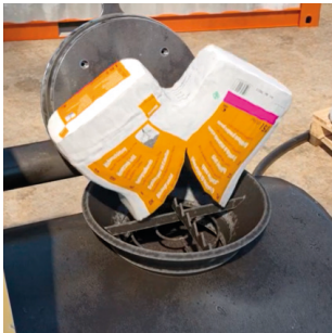
Figur 1 Tilføj fermacell bikubegranulat. (Se 0,17 sek. i montagevideoen.)
