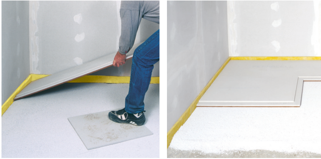
Udlægning af fermacell® Fibergips gulvelementer på fermacell™ Niveaugranulat
