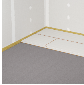
8 Udlægning af gulvelementer efter ca. 24 timer
