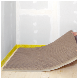
Udlægning af fermacell™ Bikubeunderlag
