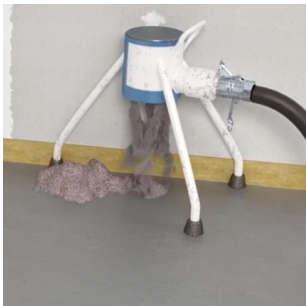
Figur 4 Udlægning af færdigblandet trinlydsgranulat. (Se 0,37 i montagevideoen.)
