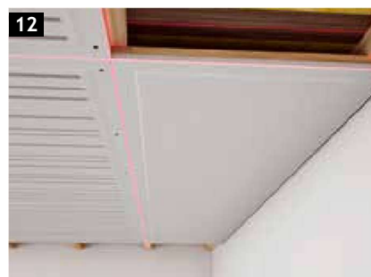
12 Pladerne langs kanterne skrues pr. 200 mm, og skal holde 5 mm luft ind mod væggene. Der afsluttes mod væggene med en overmalbar elastisk fuge.
