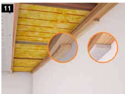
11 Anvendes en passende 12,5 mm fermacell fibergipsstrimmel.
