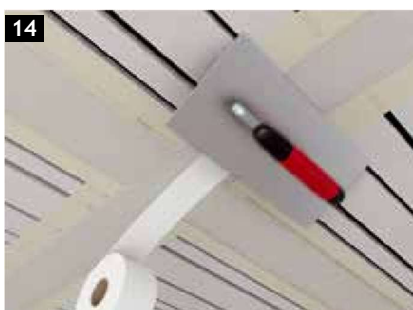
14 Til at spartle pladerne anvendes fermacell SK spartel eller fermacell Fugespartel og altid fermacell Papirarmeringsbånd. Første lag fyldes i spartelsoget og skrubes glat af med overkanten af pladerne...
