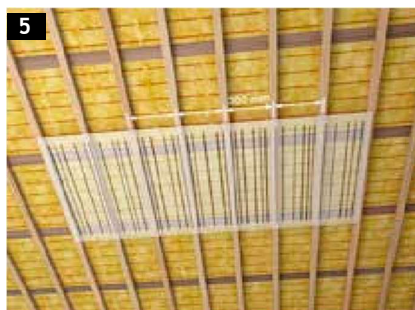
fermacell ACOUSTIC big boards monteres på en lægteforskalling på minimum 38 x 45 mm, på tværs af forskallingen med en afstand c/c 300 mm...
