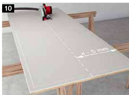
10 Anvend standard 12,5 mm fermacell Fibergipsplader med spartelkanter.
